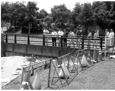
町内の被災現場を視察
