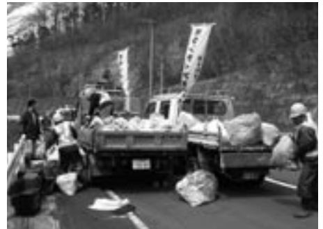
ボランティアで撤去作業する田子町建設業協会
