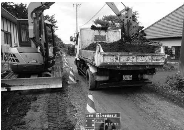
道路改良工事の様子
