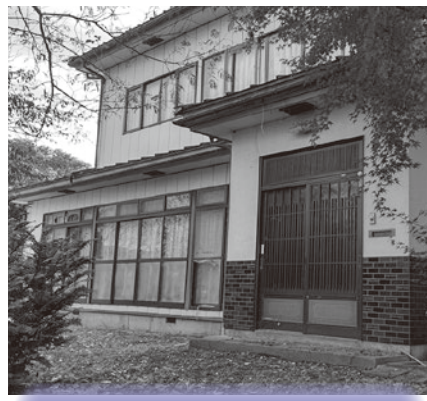
全国的に問題となっている 空き家は増え続けている
